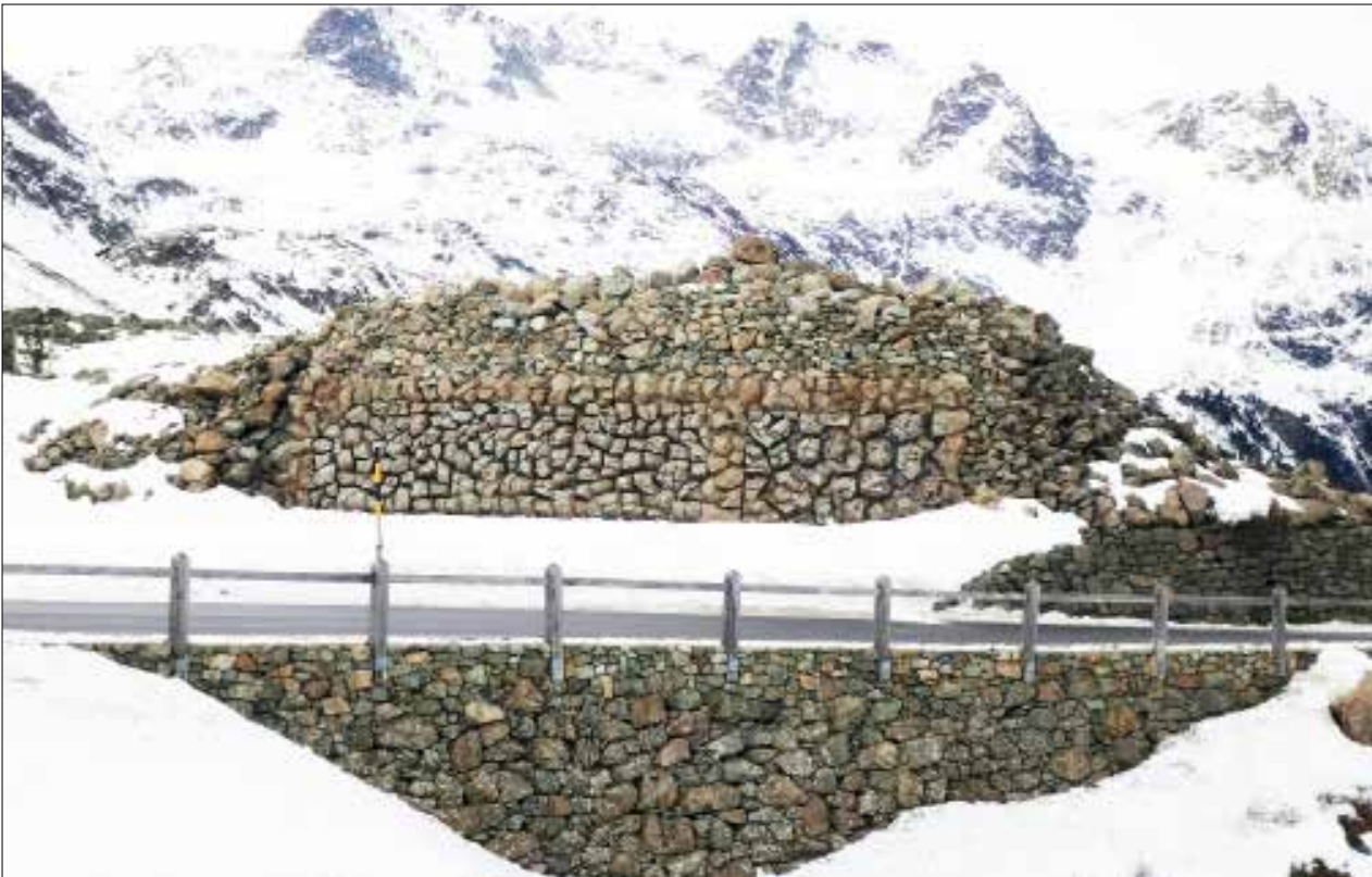
Sanierte Tarnung im Frühwinter 2016. Aus denkmalpflegerischen Gründen sind die alten Tarnungstore mit ihren Felsmodellierungen erhalten worden. Sie wurden entrostet, gerichtet, verstärkt, verzinkt, neu mit rostfreien Netzen bespannt und mit einer Spezialfarbe bemalt. Auch in den Zwischenbereichen mussten nur wenige Teile nachgebaut werden. Die zuletzt montierten Tarnungsteile müssen im kommenden Sommer noch an den farblich sehr anspruchsvollen Albula Granit angepasst werden.
