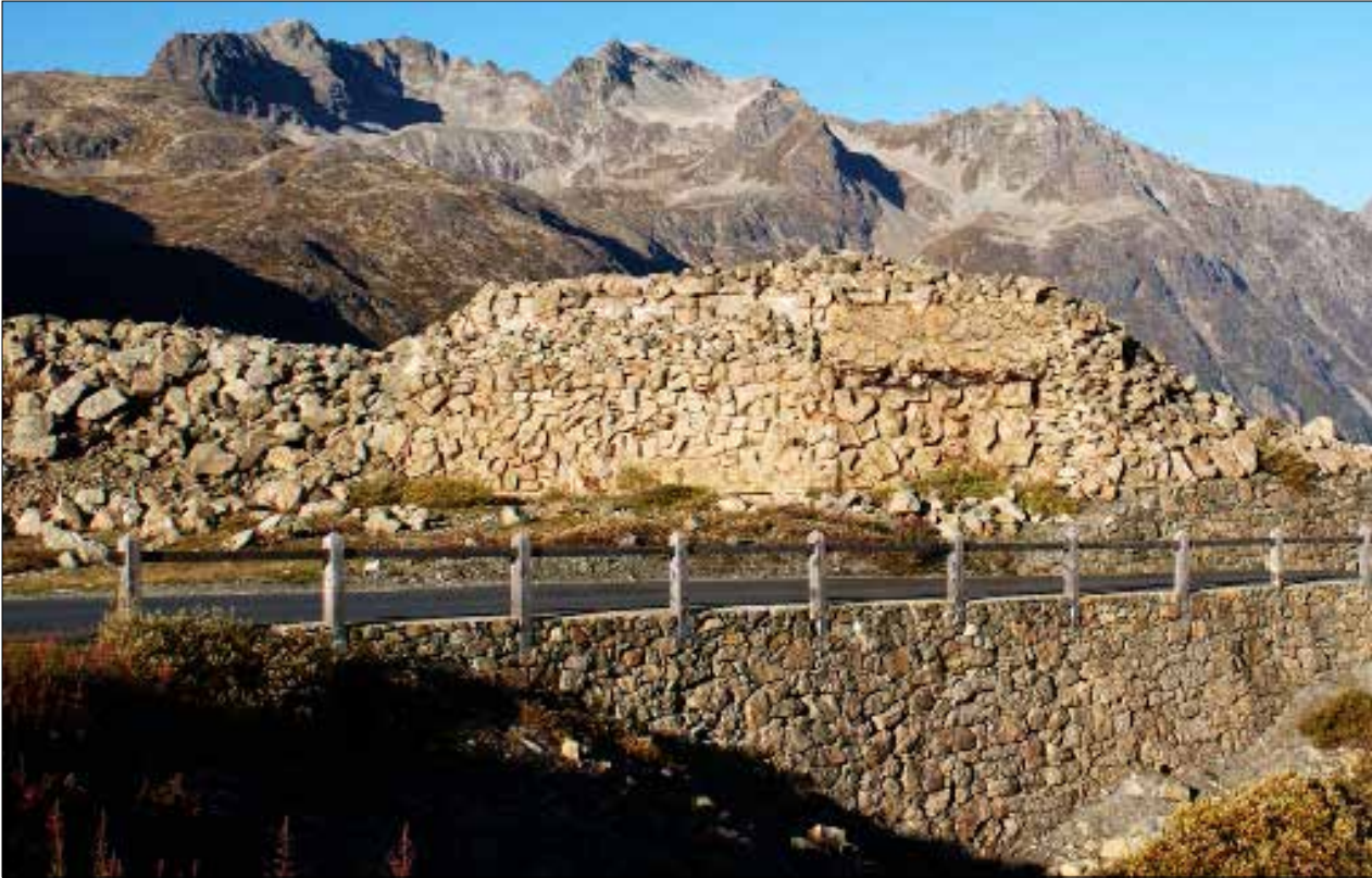
Einsturzgefährdete, abgesackte, verrostete Tarnung des Bunkers Albula Strasse vor der Sanierung.
