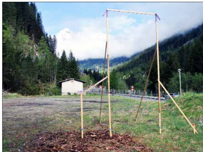
Materialmagazin Traversa mit den Bauprofilen des Steinschlagdamms entlang der A13.
